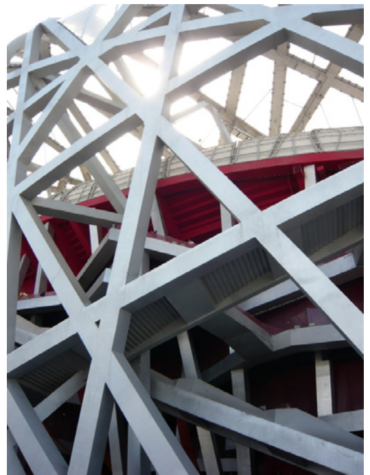
Détail en cours de construction
